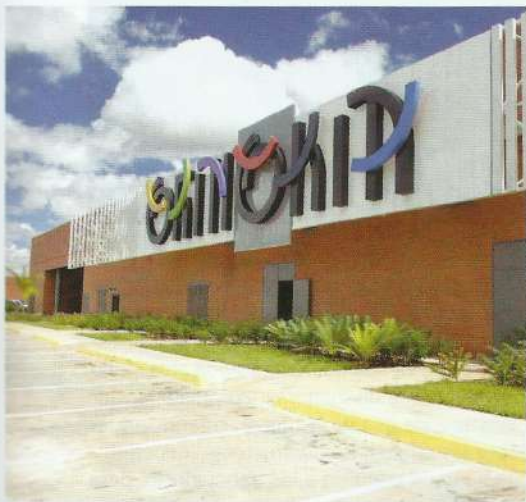
CATEGORIA INSTITUCIONAL/INDUSTRIAL Orinokia Mall, Puerto Ordaz, Edo. Bolívar. Grupo San Tomé Venezuelan Project Managers, Grupo PMA
